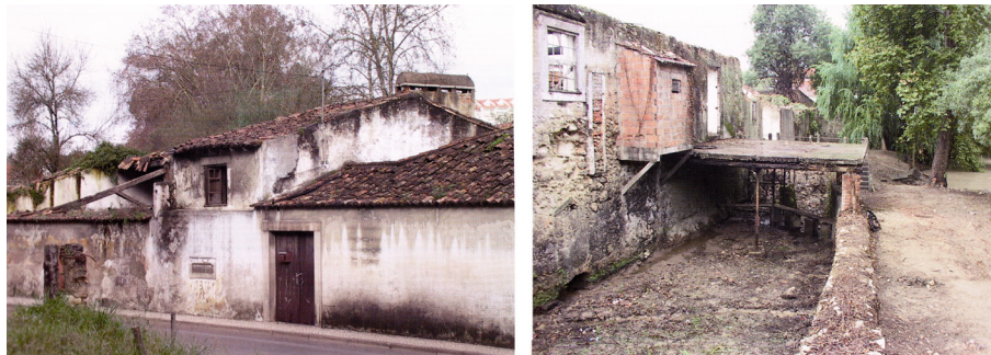
Fig. 3. Foto del mulino prima dell'intervento; a destra, piattaforma in cemento per l'attraversamento del canale.
