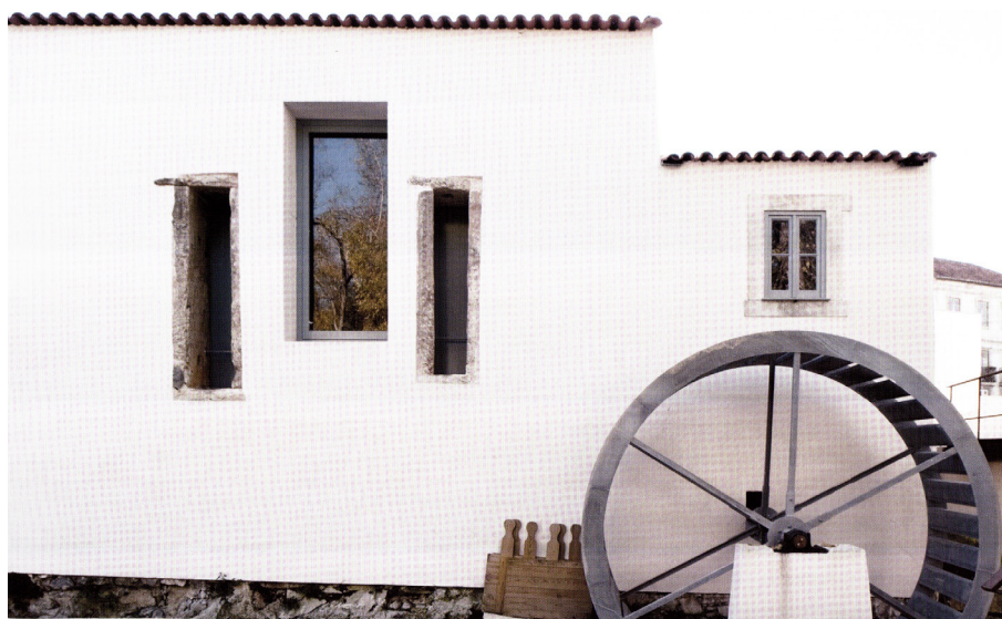
Fig. 4. Dettaglio della facciata nord con ruota idraulica in acciaio. Sotto: vista della sala delle macinazioni.
