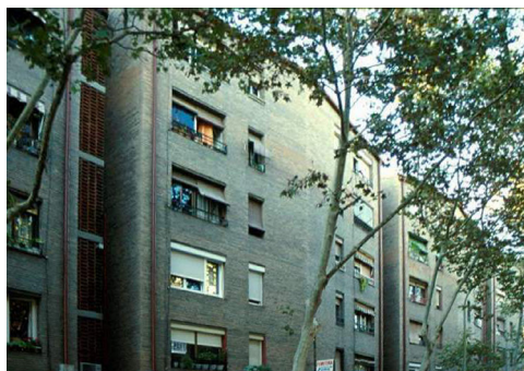
Fig. 4. J.L. Sert, Complesso residenziale “Les Escapes Park”, Barcellona, 1975 (Imm da: J.M. Rovira, Sert 1901-1983, p. 378).
