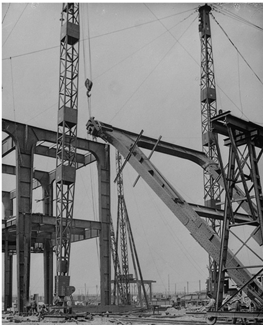
Fig. 8. Dettaglio della gru di sollevamento delle strutture in ferro (Deutsche Fotothek).
