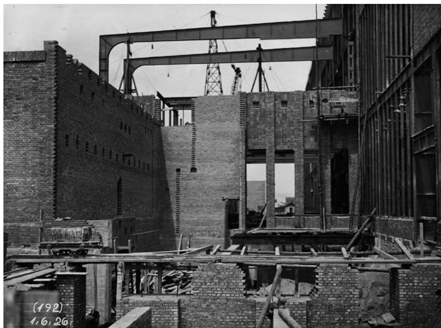
Fig. 11. Costruzione della Kleineturbinenhalle, 1926 (Bewag Archive, Vattenfall Berlin).
