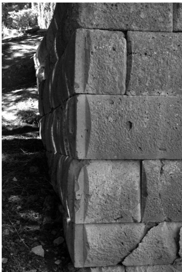
*Fig. 5. Kos, Asklepion, dettaglio del muro di terrazzamento tra la terza e la seconda terrazza. La struttura, in opera quadrata di travertino locale, mostra un bugnato 'a bauletto' con elegante bisellatura a diamante (foto dell'A.).*
