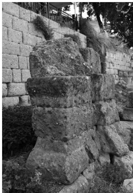
Fig. 8. Kos, Stoà di Tufo: basamento di uno dei vani interni con modanature di base e coronamento semplificate (foto dell'A.).
